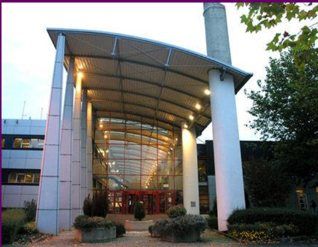
Entrée Général Electric
